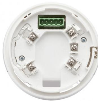
La base avec sirène incorporée art. 41SAB000/IS est alimentée par la boucle et contrôlée par la centrale à travers le protocole de communication. Possibilité de monter un détecteur directement sur la base avec sirène afin d'exploiter au maximum l'espace disponible. Certification EN54-3.
